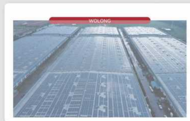
农牧光储一体化系统
