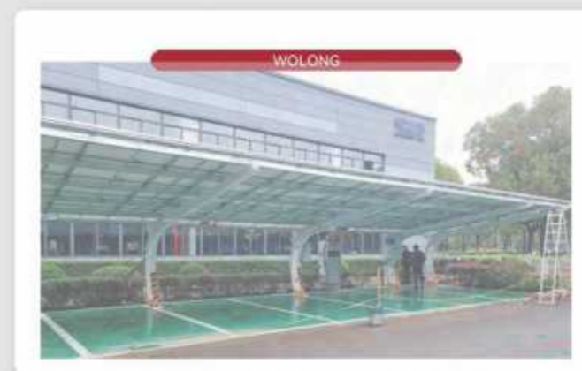
园区光储充一体化系统
