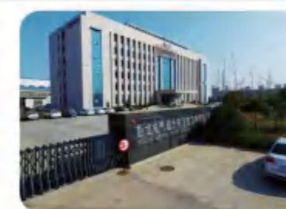
北京/烟台 | 储能变压器 Beijing&Yantai - Transformer
